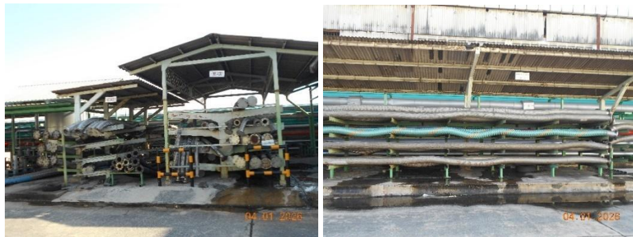
รูปที่ 1.8.12-1 โครงหลังคาเก็บท่อสูบน้ำเคมีภัณฑ์จากเรือ (Hose Rack)
