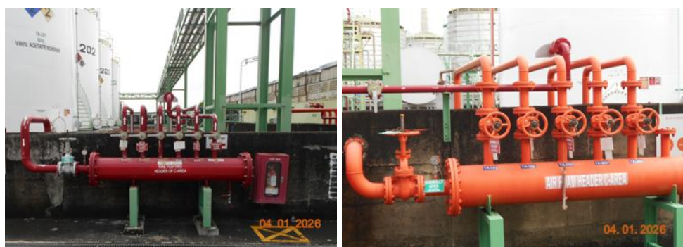
รูปที่ 1.8.3-6 (ซ้าย) ท่อดับเพลิงและ (ขวา) Air foam Header Zone 3 : C-Area
