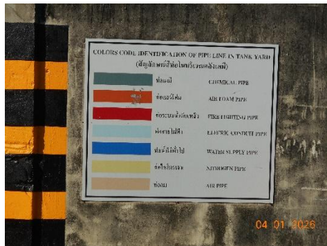
รูปที่ 2.5.3-1 สัญลักษณ์สีท่อต่างๆ ภายในบริเวณคลังเคมี รูปที่ 2.5.3-2 สัญลักษณ์ NFPA แสดงอันตรายของสารเคมีที่อยู่ในถังเก็บสินค้า
