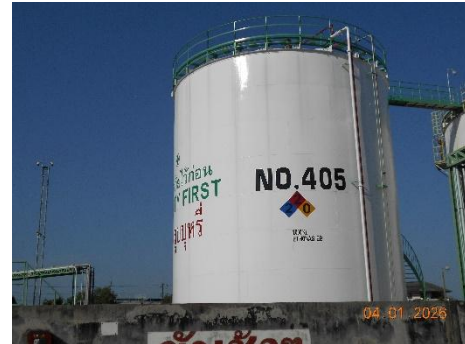
รูปที่ 2.5.3-1 สัญลักษณ์สีท่อต่างๆ ภายในบริเวณคลังเคมี รูปที่ 2.5.3-2 สัญลักษณ์ NFPA แสดงอันตรายของสารเคมีที่อยู่ในถังเก็บสินค้า
