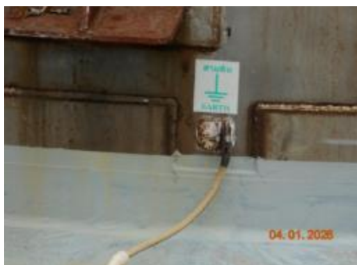
รูปที่ 2.4-2 การทำถังเก็บให้เป็นกลางโดยการต่อสายดินเพื่อป้องกันไฟฟ้าสถิตย์
