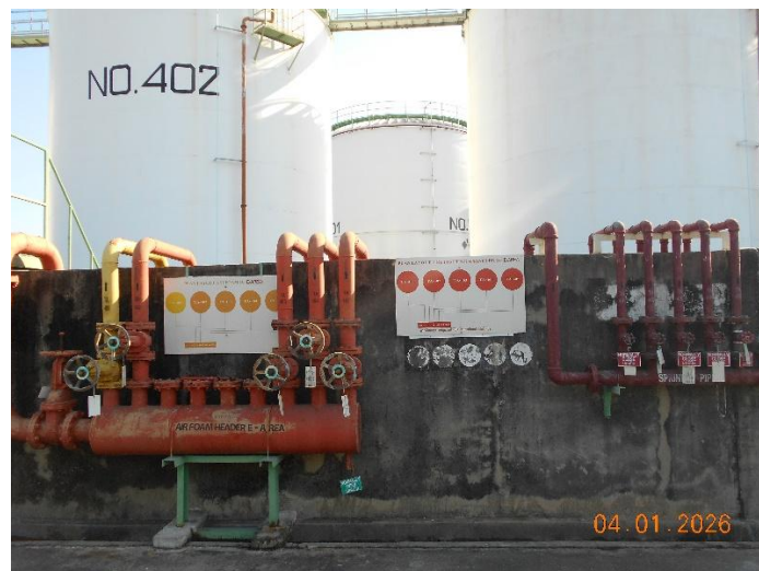
รูปที่ 1.8.3-13 ท่อดับเพลิง และ Air foam Header Zone 6 : E-Area
