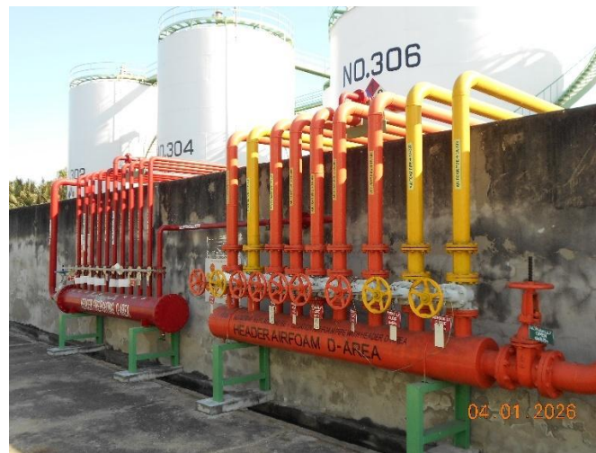
รูปที่ 1.8.3-11 ท่อดับเพลิง และ Air Foam Header Zone 5 : D – Area
