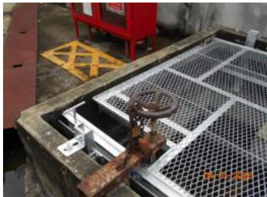
รูปที่ 2.1-2 วาล์วช่องระบายน้ำจะปิดตลอด เพื่อป้องกันน้ำในแม่น้ำเจ้าพระยาไหลย้อนกลับเข้ามาในบ่อแยกน้ำมัน (Oil Separator) ในช่วงเวลาน้ำขึ้น
