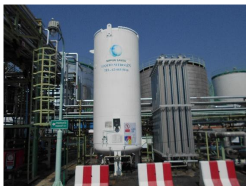
รูปที่ 1.8.17-1 ถังเก็บไนโตรเจนเหลว
