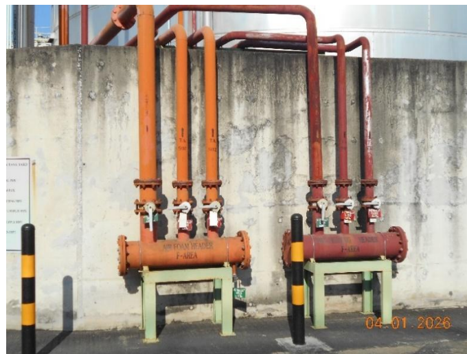
รูปที่ 1.8.3-15 ท่อดับเพลิง และ Air Foam Header Zone 7 : F-Area
