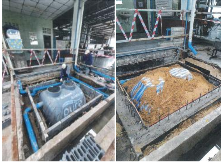
รูปที่ 1.16-5 ระบบระบายน้ำเสียสำหรับห้องสุขาภายนอก
