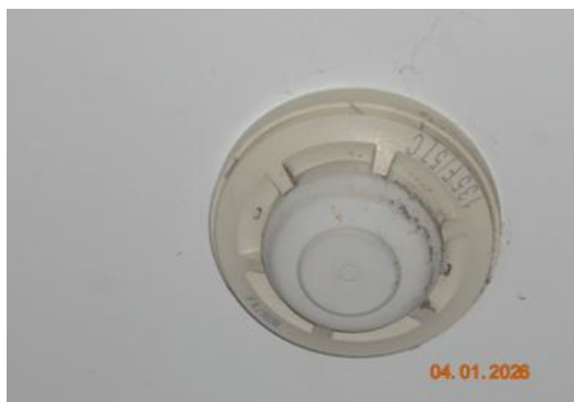
รูปที่ 2.5.3-3 เครื่องตรวจจับความร้อน (Heat detector) ไว้ที่เพดานของสำนักงาน
