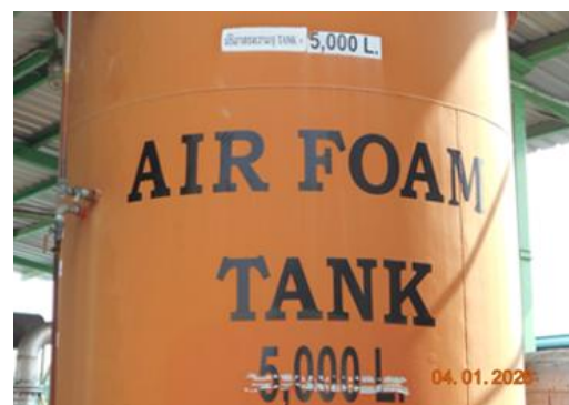
รูปที่ 2.5.3-4 ถังแอร์โฟมดับเพลิงภายในโครงการ
