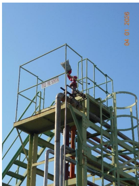
รูปที่ 1.8.3-7 หัวฉีดน้ำดับเพลิงที่ C- Area
