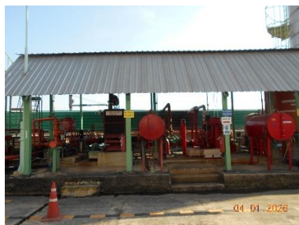
รูปที่ 1.8.10-1 เครื่องสูบน้ำเครื่องที่ 1, 2 และ 3 ตามลำดับ (Fire Pump)
