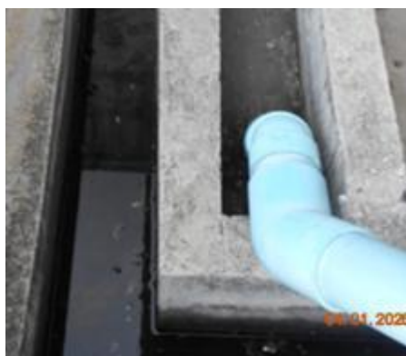
รูปที่ 2.1-4 รางระบายน้ำรอบลานถังเคมี (ทุก ZONE) ที่จะเข้าบ่อแยกน้ำมัน (Oil Separator) มีการทำความสะอาด ทุกๆ เดือน หรือในระยะเวลาที่เหมาะสม ถ้าเห็นว่าภายในบ่อมีคราบสกปรก และตะกอนตกค้างมาก เพื่อลดตะกอนและคราบน้ำมันที่จะเข้าสู่ระบบบำบัด
