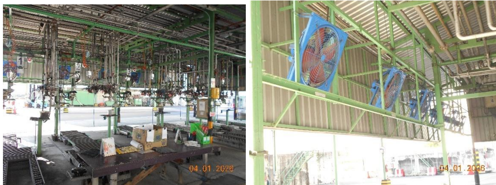
รูปที่ 1.8.7-2 สถานีจ่ายเคมีภัณฑ์ลงถัง 200 ลิตร (Drum Station) มีการติดตั้งพัดลมระบายอากาศ
